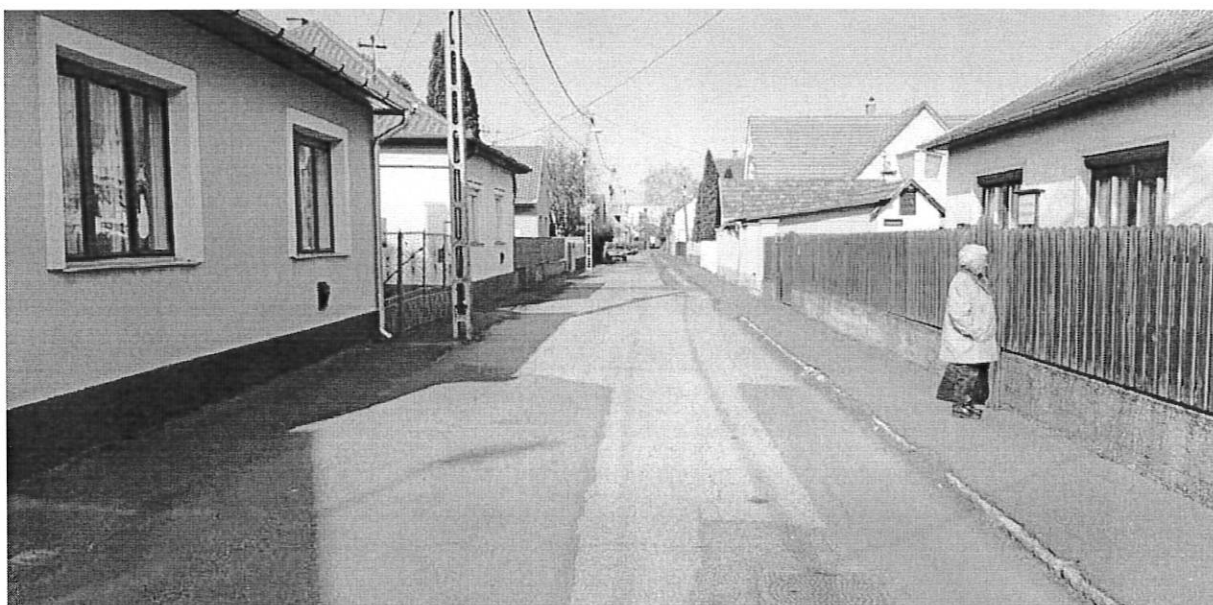
A Kígyó utcában több helyen az útburkolat szélénél vannak a közvilágítás tartó oszlopok.
